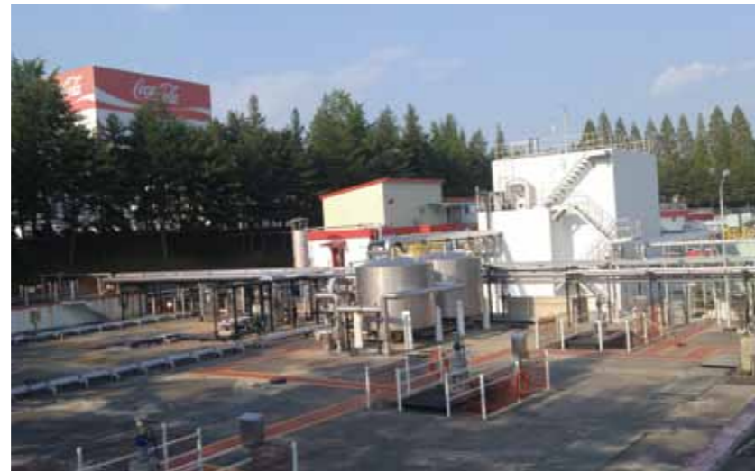
여주공장 폐수처리장 전경
