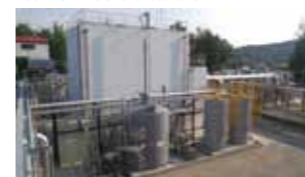
여주공장 혐기성처리시설 설치
