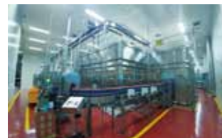
여주공장 용수절감형 신생산설비 설치
